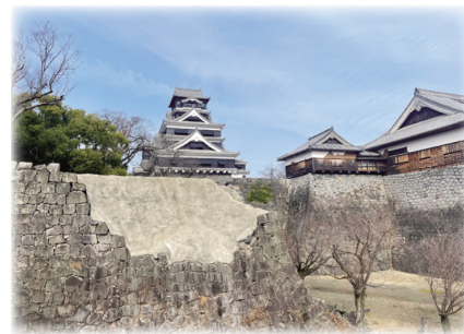
熊本城の復旧風景
