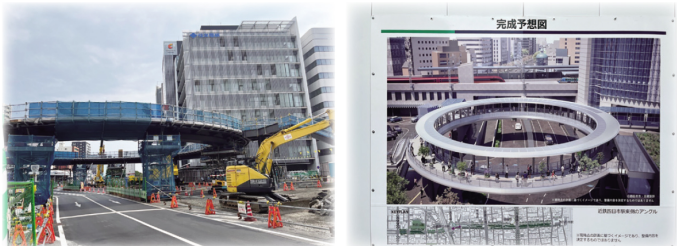
円形デッキ建設現場
