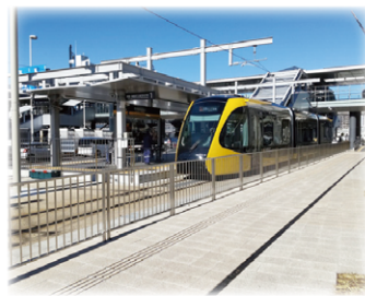
宇都宮駅東口LRT停留場の様子
