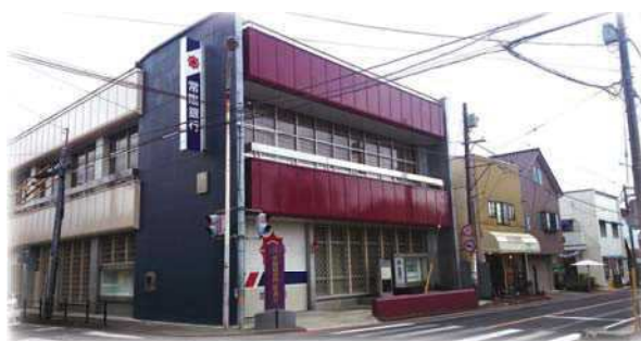
図 5 笠間朱色を取り入れた外壁
