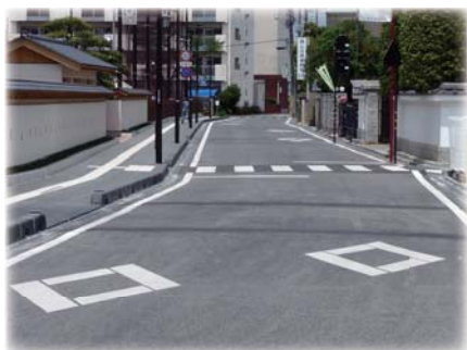
歴史的景観に配慮した道路
