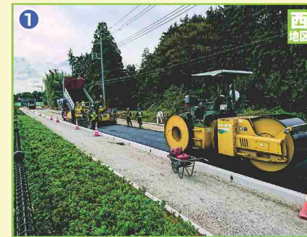
1 街路築造工事
