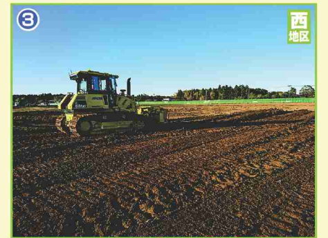
3 宅地造成工事(大街区)
