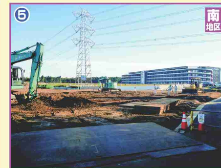
5 宅地造成工事
