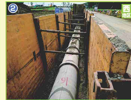
2 下水道工事(雨水管)
