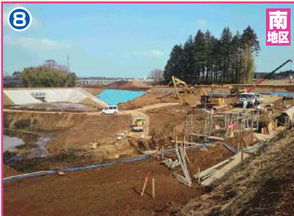
第3調整池築造工事
