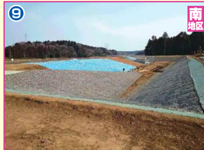
第2調整池築造工事
