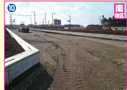
道路築造工事
