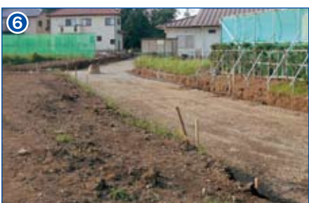
6 区画道路築造工事(3BL周辺) (各工事現場撮影日：平成22年9月21日)
