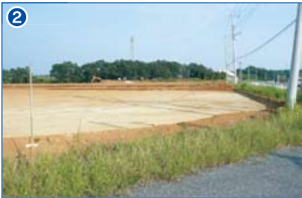
2 宅地完成工事(計画建設街区)
