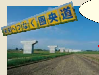
工事が進む(仮称)水海道IC周辺(常総市)
