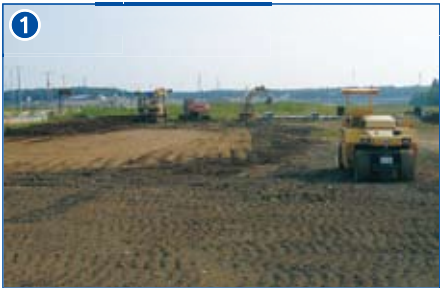
1 宅地完成工事(治道施設街区)
