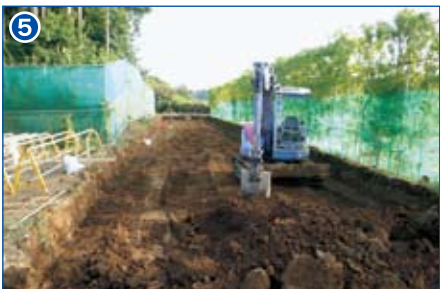
5 区画道路築造工事(36BL周辺)
