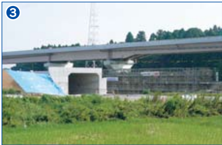
3 幹線道路築造工事(竜ヶ崎阿見線BP橋梁)
