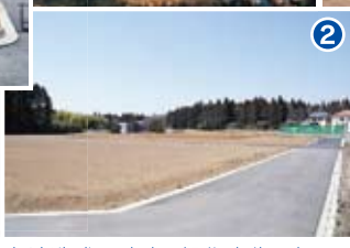
宅地完成工事(一般住宅街区)
