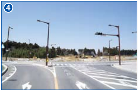
幹線道路築造工事(赤太郎通り線)
