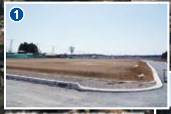
宅地完成工事(沿道施設街区)
