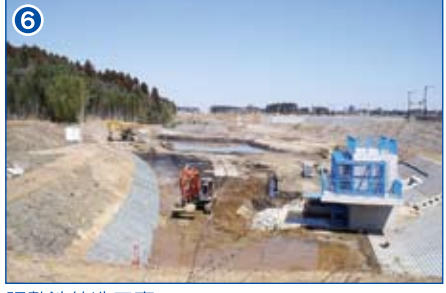
調整池築造工事
