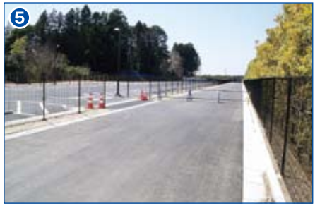
区画道路築造工事(36BL周辺)
