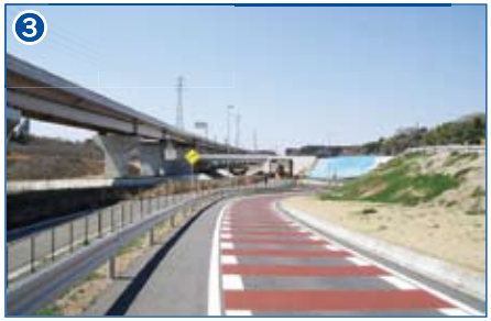
幹線道路築造工事(竜ヶ崎阿見線BP橋梁)
