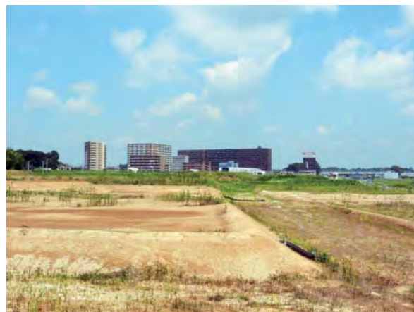
② 大規模緑地北側の造成工事予定箇所の様子
