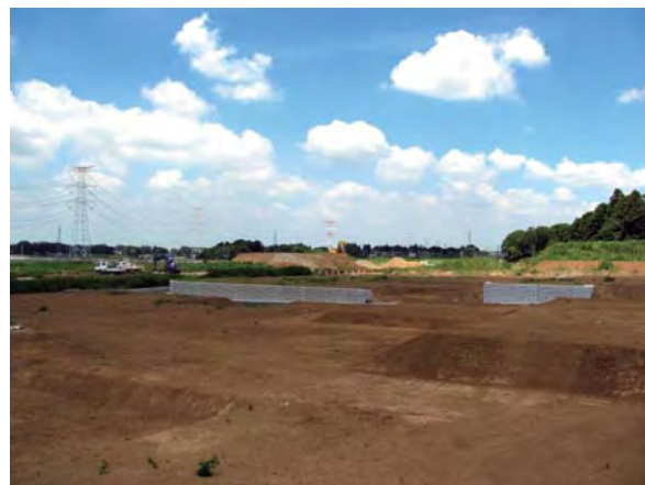
③ 新都市中央通り線沿いの造成工事の様子
