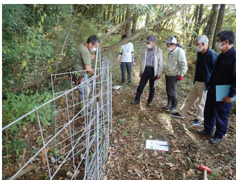
侵入防止柵の設置状況の点検
