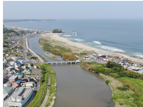
大北川（河道掘削）【北茨城市】
