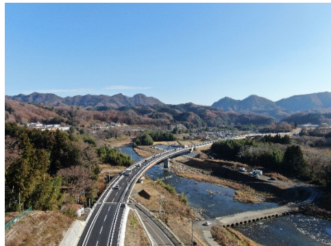
国道118号袋田バイパス【大子町】
