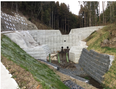
中嶋入沢（堰堤整備）【常陸大宮市】
