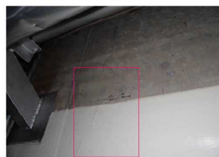
原子炉建屋5階壁面
