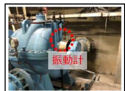
ポンプへのセンサ設置状況
