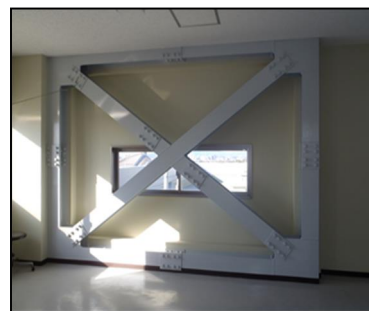
【建築物の耐震補強】
