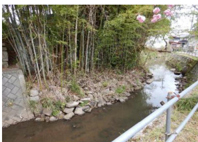
護岸整備 観音川(桜川市)
