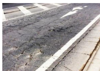
舗装修繕 茨城鹿島線(鹿嶋市)
