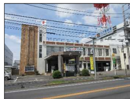
古河警察署現況 (S41年3月築)
