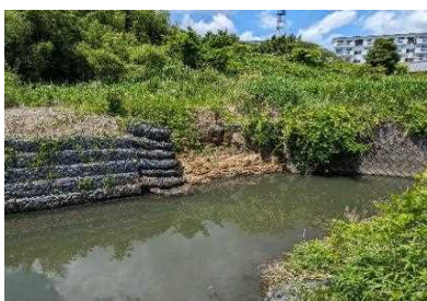
護岸改修 沢渡川(水戸市)
