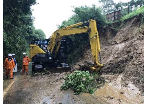
写真1 2023年梅雨前線による大雨及び台風第2号（法面崩壊箇所への応急復旧）
