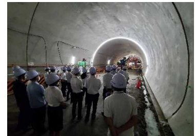
写真7 トンネル工事現場見学会
