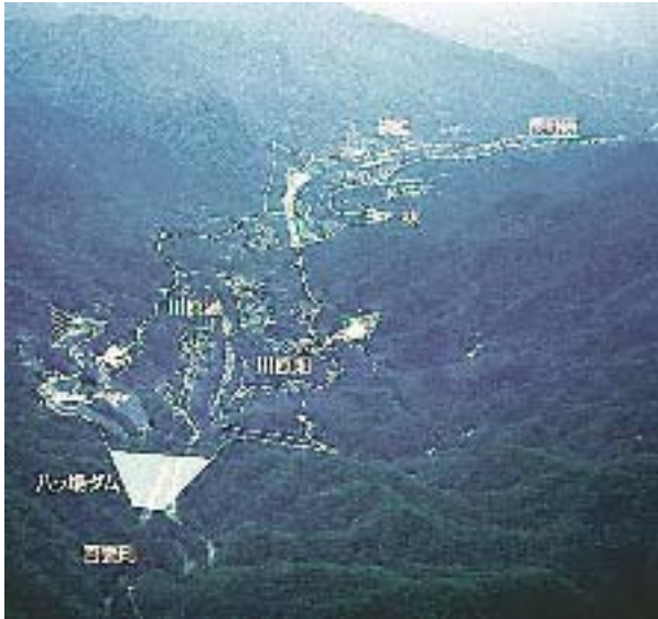
ハツ場ダム建設予定地
