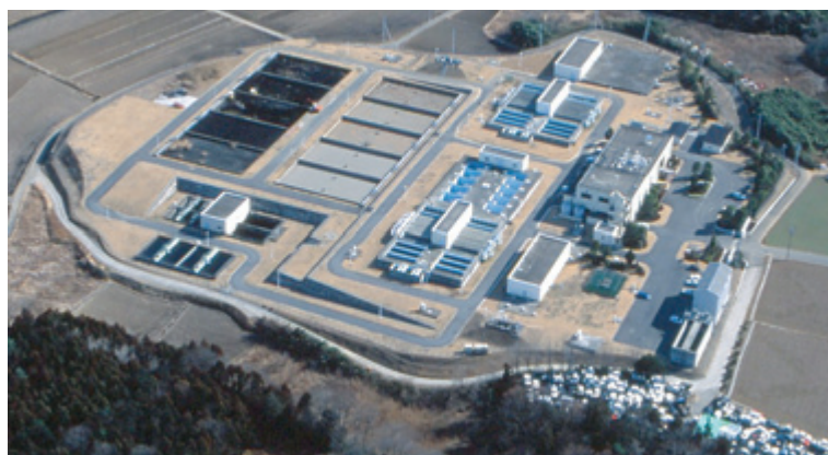
高度浄水処理施設の導入が予定される水海道浄水場
