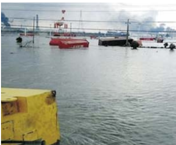
津波浸水時の鹿島港北公共ふ頭(鹿嶋市・神栖市)
