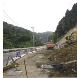
常陸太田那須烏山線の法面復旧工事(常陸太田市棚谷町)
