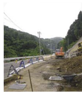
常陸太田那須烏山線の法面復旧工事 (常陸太田市棚谷町)
