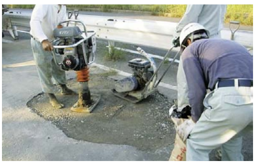
道路の補修工事の様子
