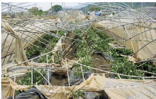
倒壊したパイプハウス(つくば市)
