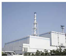
東海第二発電所(東海村)
