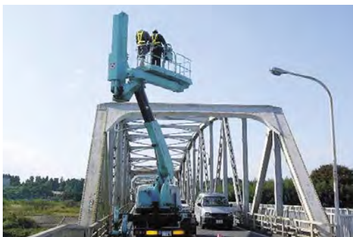
公共インフラの総点検を(千歳橋点検の状況:水戸市)
