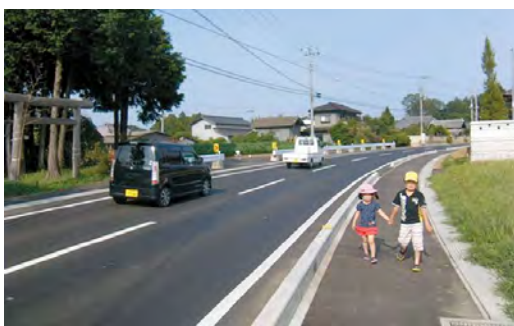
歩道設置により歩行者の安全が確保された道路
