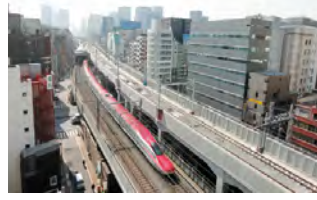
常磐線の東京駅乗り入れ工事の様子
