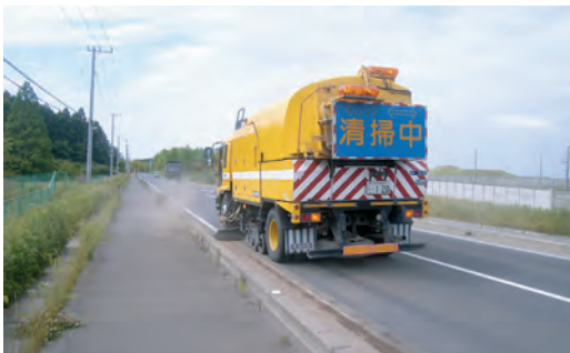
縁石周りの土砂・雑草の撤去
