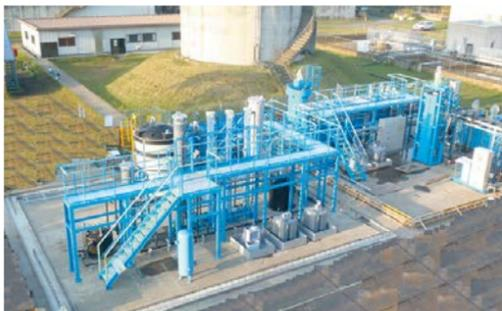
新しい高度浄水処理技術の実験施設(霞ヶ浦浄水場)
