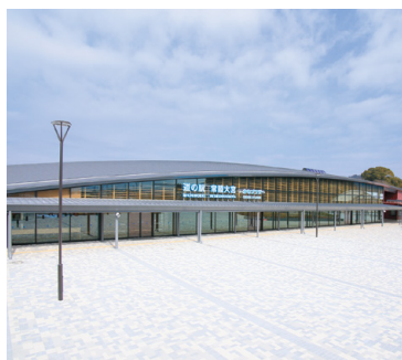
道の駅を防災拠点として重点化
