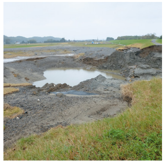
台風により損壊した水田
