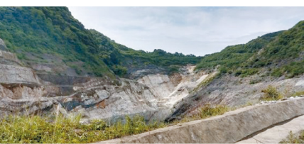
新産業廃棄物最終処分場整備候補地の状況
