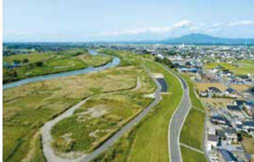
整備が進む県内河川(鬼怒川・常総市上三坂地先)
