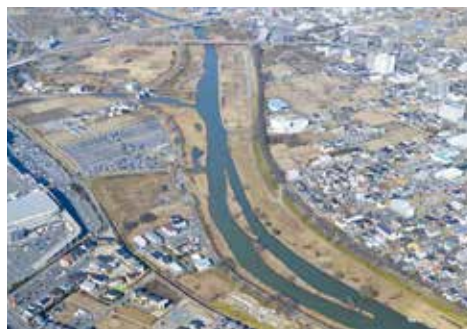
桜川の掘削予定箇所
