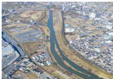
桜川の掘削予定箇所
