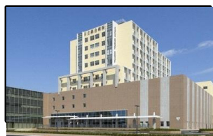
（株：日立製作所日立総合病院）
