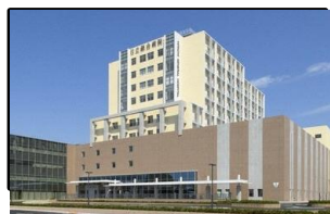
（株：日立製作所日立総合病院）
