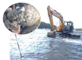
重機を活用したアユの産卵場造成
