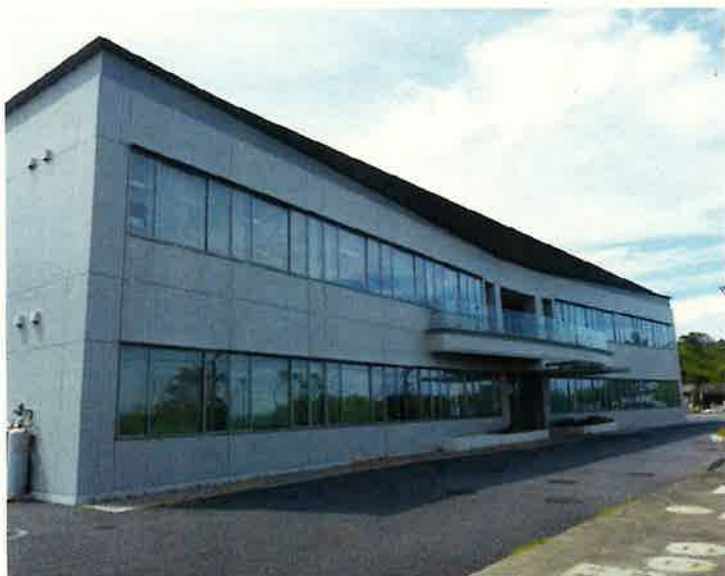
水産試験場 本館
