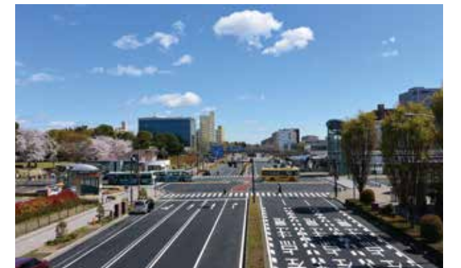
電線類が地中化されたTXつくば駅前
