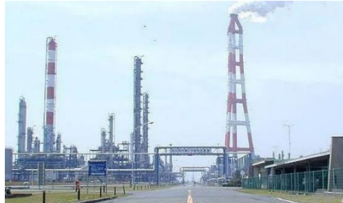
ケミカルリサイクル設備を建設中の三菱ケミカル(株)茨城事業所
