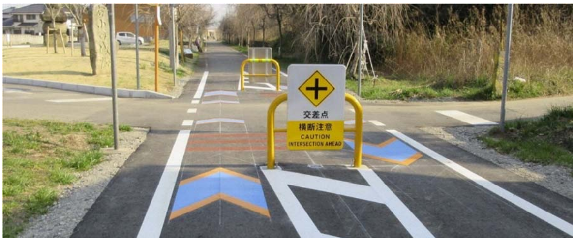
図 8.16 矢羽根・交通安全施設の例 (つくば霞ヶ浦りんりんロード)
