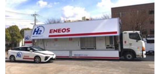
つくば春日水素ステーション (出典：JXエネルギー(株)HP)
