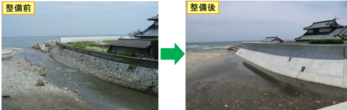
図〇〇-● 海岸や河川河口部の堤防の嵩上げ状況（小木津海岸（日立市））
