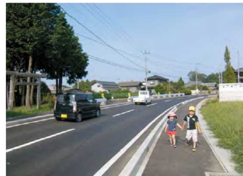
図〇〇-● 歩道設置により歩行者の安全が確保された道路
