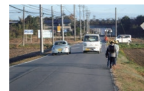
計画的な歩道の整備(整備前)
