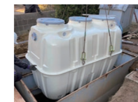
高度処理型浄化槽の設置
