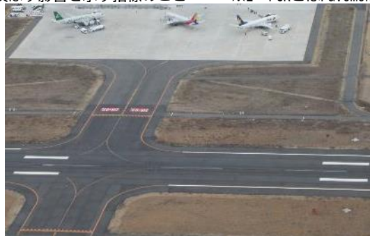
滑走路の舗装
