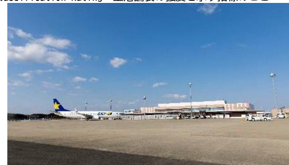
駐機場の舗装
