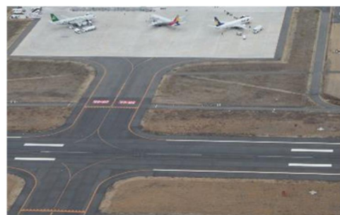
滑走路の舗装
