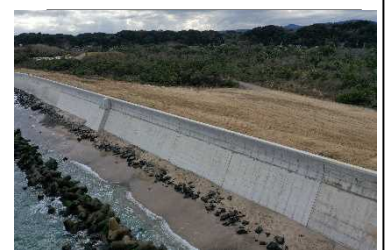
海岸防災林を守る防潮護岸工
