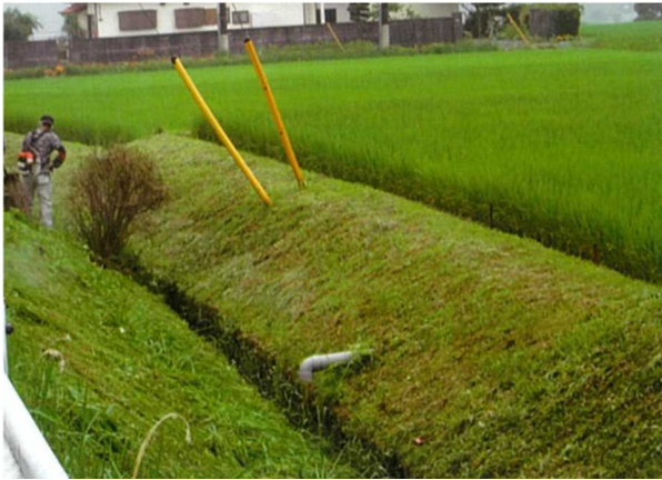
排水路法面の管理
