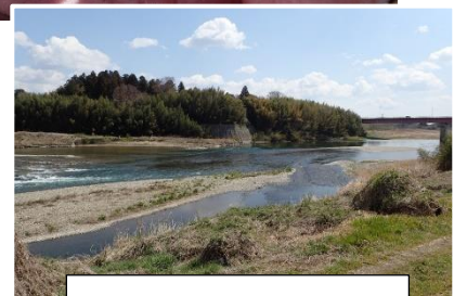
4月2日 那珂川千代橋の様子
