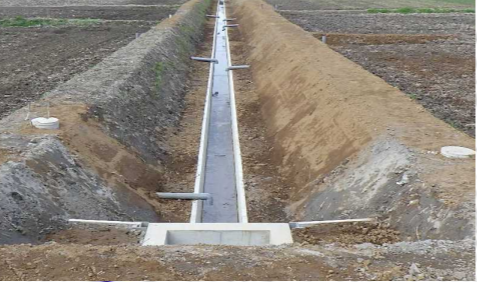
施工後(フリューム化で排水性の改善)
