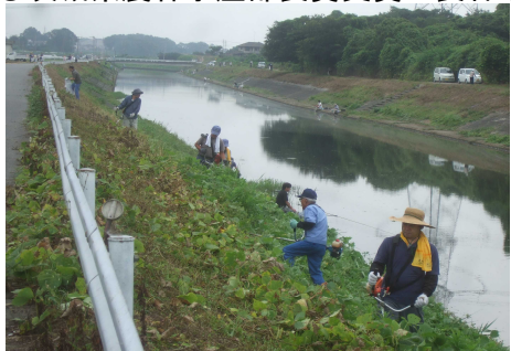
水路の草刈りの様子
