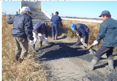
農道の砂利補充作業の様子
